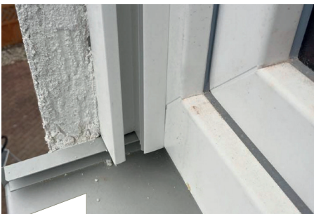
Nicht nur der Bereich der Putzanschlüsse muss beim Einbau von Fenster geregelt werden, aufgrund der regionalen Unterschiede in Deutschland müssen auch alle andere Anschlussarbeiten erfasst werden.
